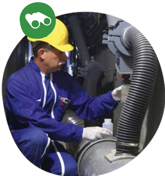
Prise d'échantillon dans le Réseau séparatif gravitaire enterré
