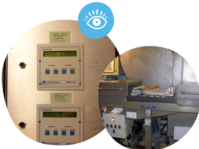
Débitmètre venturi HYDROLOGIC
